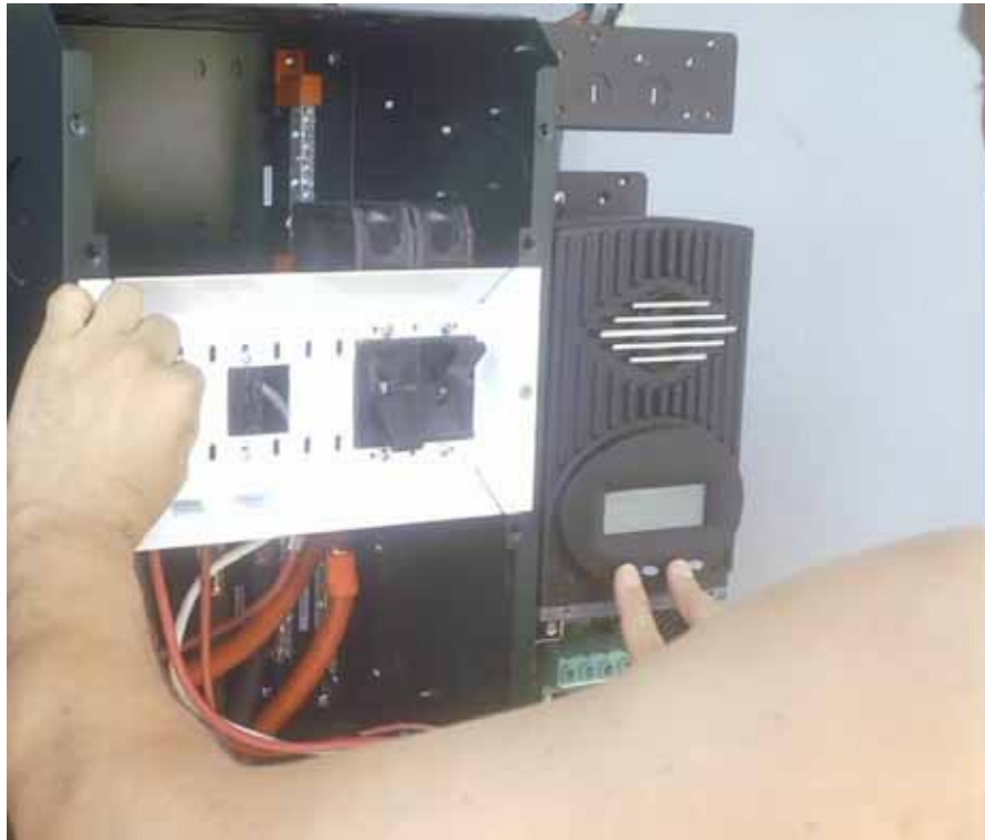
Fig. 5 Encendiendo el equipo por primera vez.
